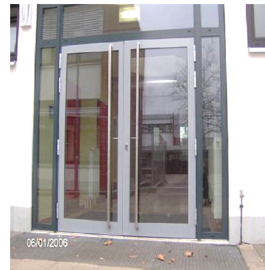
Wymiana okien i drzwi (poprawa wartości współczynnika przenikania ciepła)
