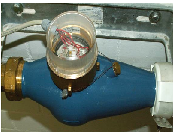
Licznik zużycia wody z zapisem danych
